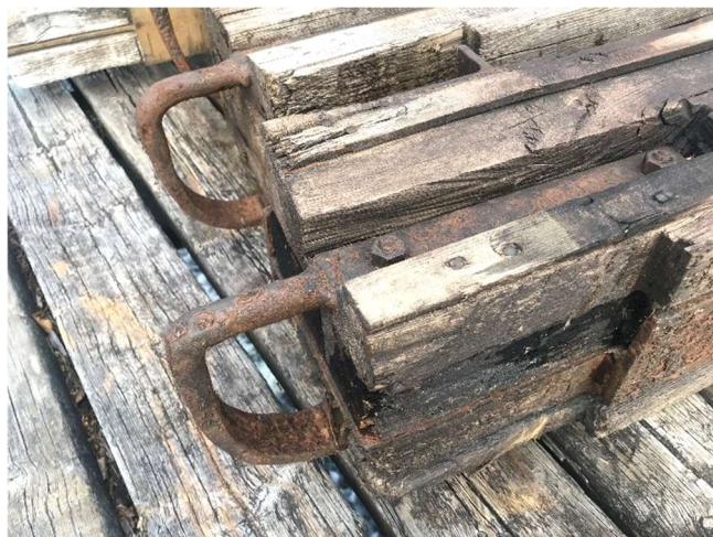
Bild 2. Detaljbild sättande med "lyftögla".
