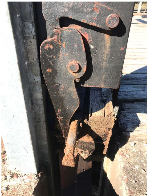
Bild 5. Lyftblocket med "låsbrickan" i läge för nedsättning av sätt.
