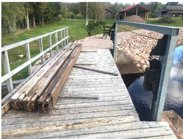
Bild 1. Sättarna förvaras på brobanan när de inte är ilagda.
